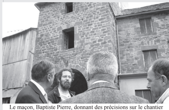
Le maçon, Baptiste Pierre, donnant des précisions sur le chantier
